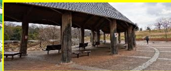
④実りの里休憩所
